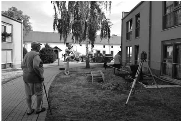
Interessiert verfolgen Bewohner des Friederikenstifts das Entstehen neuer Balkone
