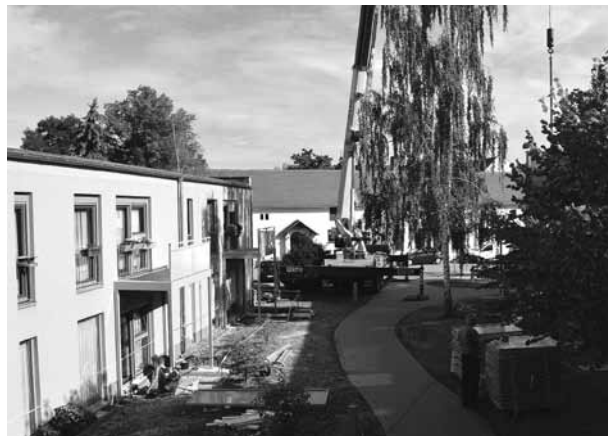
Balkone für die Wohnungen im Obergeschoss und neue Terrassen für die Erdgeschoss-Wohnungen
